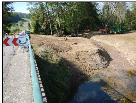
En cours de travaux
