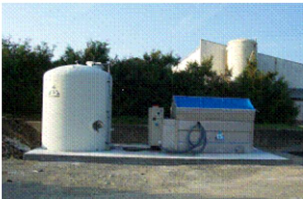
Exemple de station saumure avec cuve de stockage associée de 15 m<sup>3</sup>
