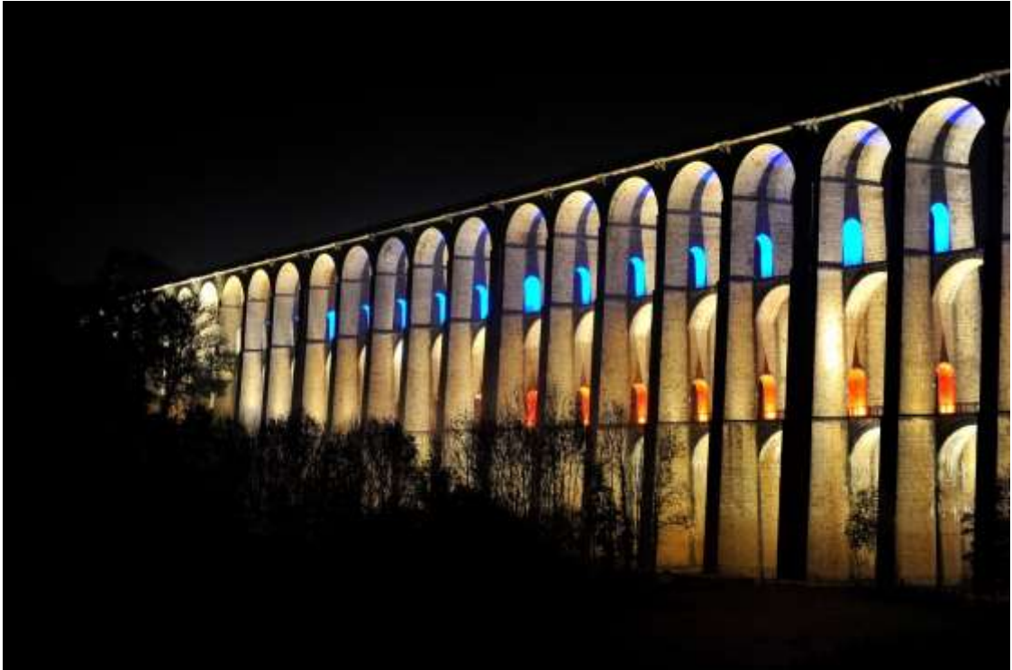
Philippe Lemoine Haute Marne CHAUMONT Viaduc
