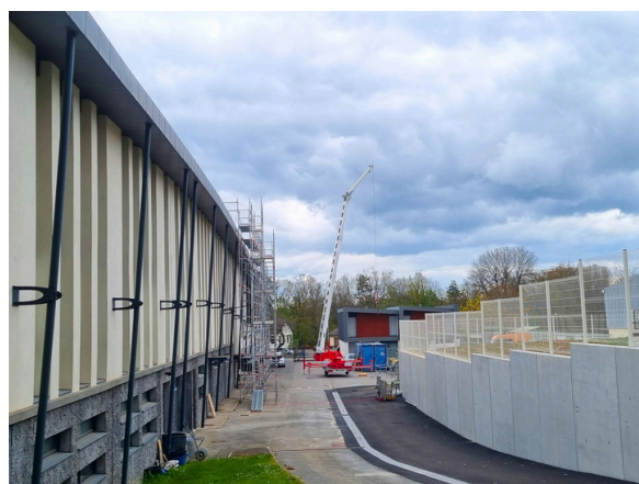
Collège La Rochotte en travaux en 2024
